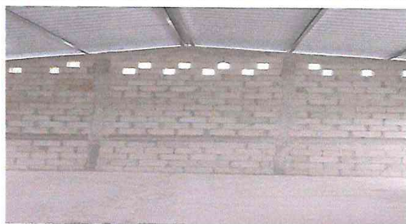
Foto 3: Elevación lateral interior.
